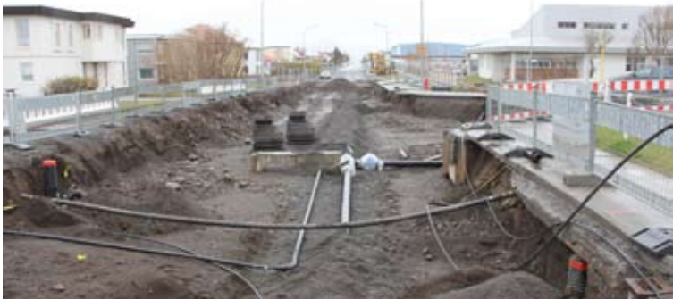
Framkvæmdasvæðið við Vesturgötu á Akranesi, séð frá götunni við Merkigerði. Búið er að skipta um allar lagnir og til stendur að malbika í næstu viku.
